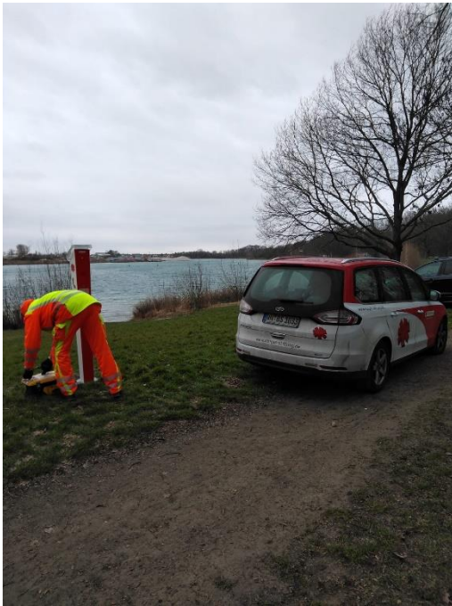
Mitarbeiter der Björn Steiger Stiftung bei der Installation der Säule
